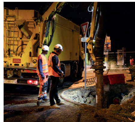
Travaux de géothermie.
