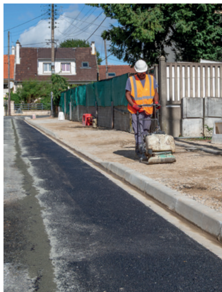
Réfection des trottoirs.
