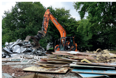
Démolition du centre de loisirs Robespierre.
