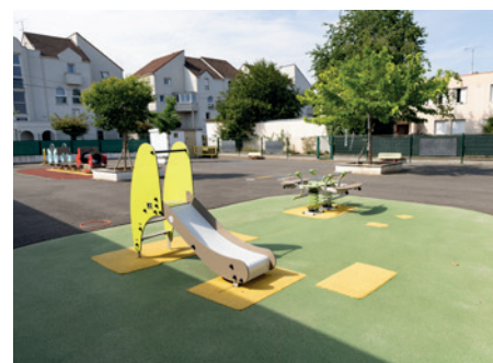
Travaux d'été dans les écoles.
